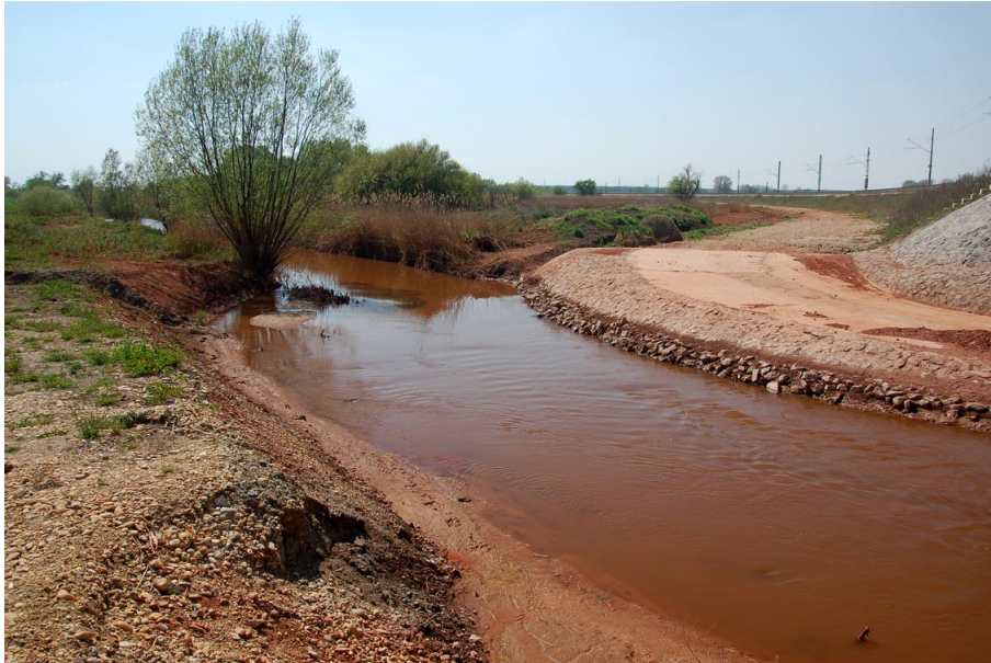
8. kép: A Marcal Bobánál, a Torna torkolata alatt
